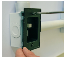
Figura 6 - Parafuse a Base na parede
